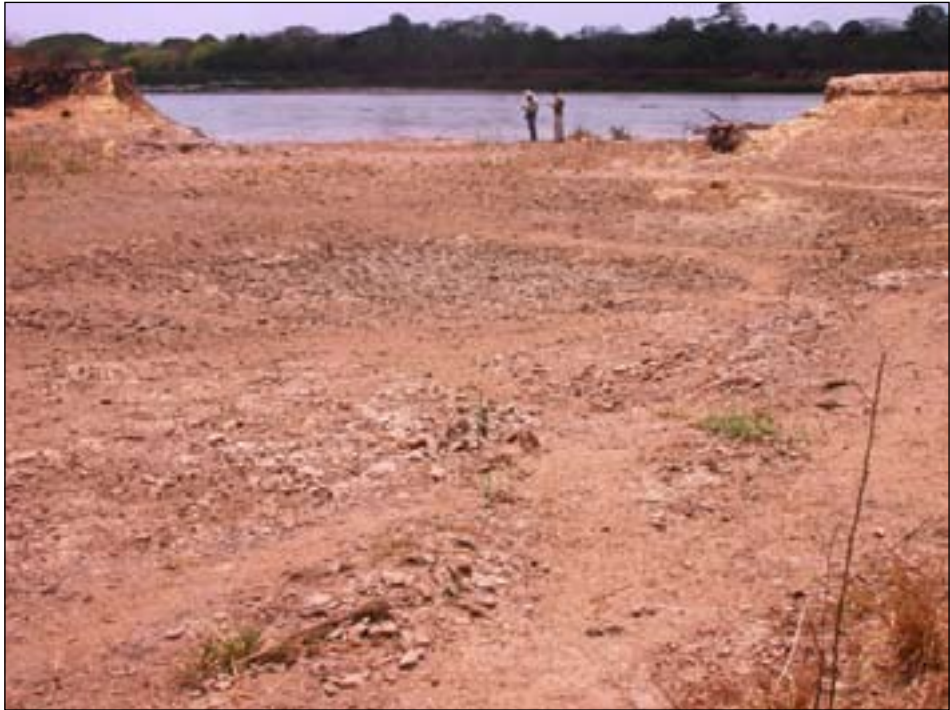
FIGURA 19.- Punto de ruptura de terraplén que orla el río Apure, cuyo cauce aparece al fondo. En primer plano se ve el rastro de la avenida de la irrupción de las aguas en la sabana. Fotografía tomada en la época seca por Rafael Antelo.
