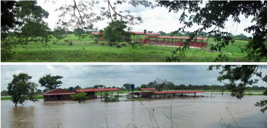
Figura 2. Evento de inundación que afecta instalaciones ganaderas en una finca en las márgenes del río Apure, en la vía Bruzual-Puerto Nutrias (estado Apure); a pesar de la buena infraestructura construida, por motivo de las inundaciones periódicas debe sacarse el ganado de allí (fotos: arriba julio 2014 y abajo junio 2011).
