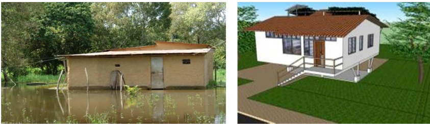
Figura 4. A la izquierda, vivienda bajo el efecto de la inundación en el estado Apure, en la vía Bruzual-San Fernando de Apure, en julio de 2005. A la derecha el concepto VIDA, propuesto por Mendoza y col. (2012); en este modelo de vivienda la separación del sustrato evitaría en parte los daños por inundación.
